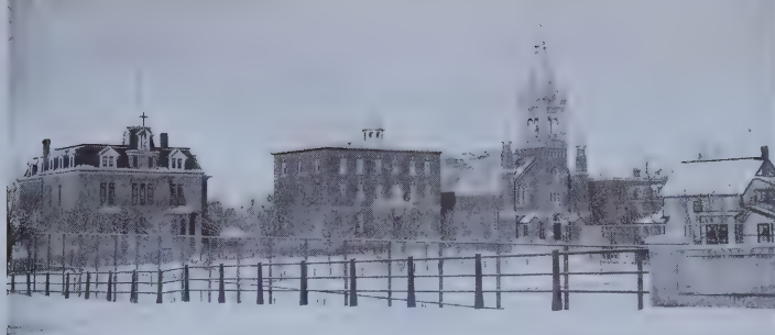
Le couvent des Fidèles compagnes de Jésus, la Maison provinciale, l'église Saint-Joachim et le Scolasticat. (APA)
