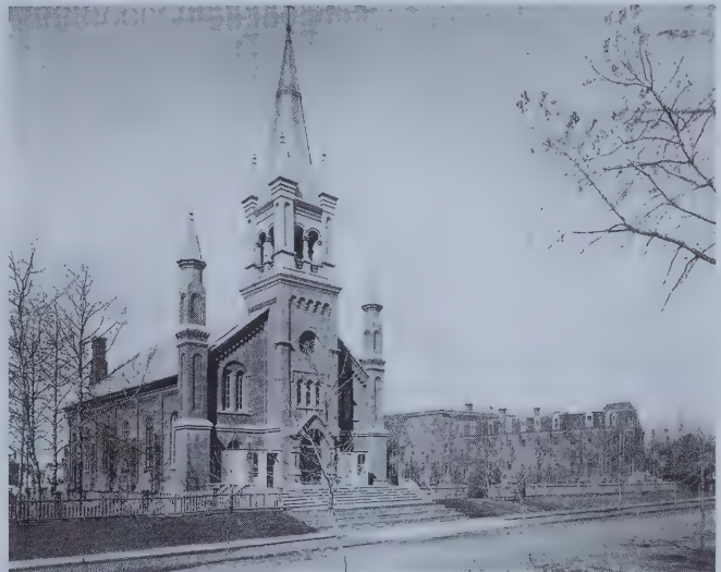
L'église Saint-Joachim et le Scolasticat ouvert en 1917. (APA)
