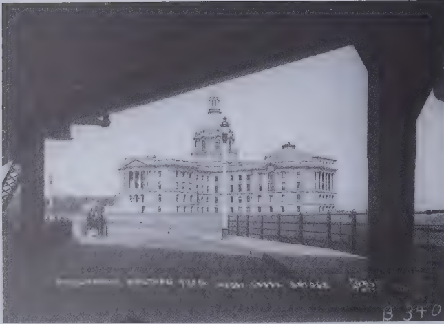
La Législature vue du pont High Level. (APA)
