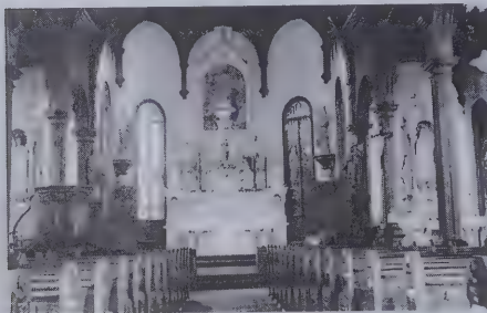
L'intérieur de la quatrième église Saint-Joachim. (APA)
