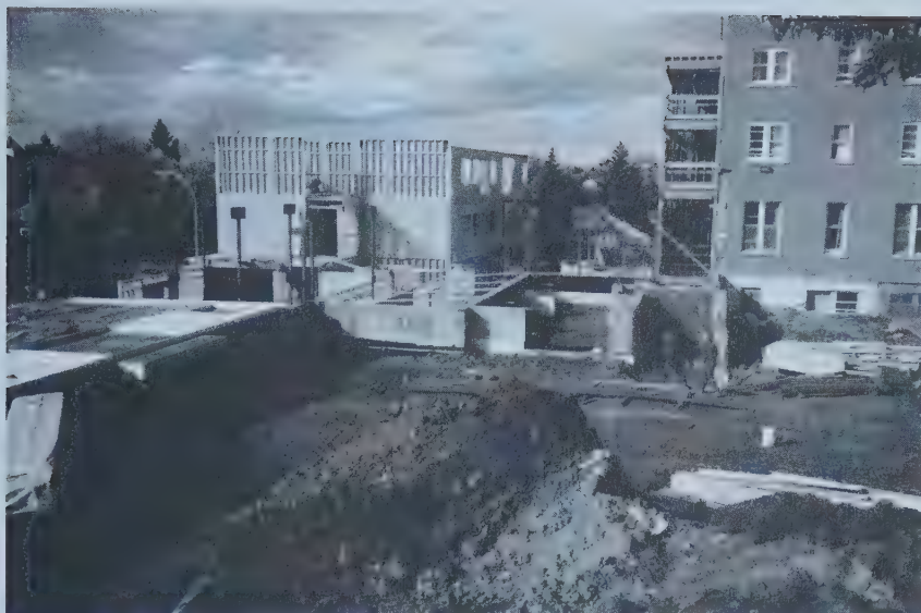
La nouvelle résidence de la Faculté Saint-Jean est en construction.
