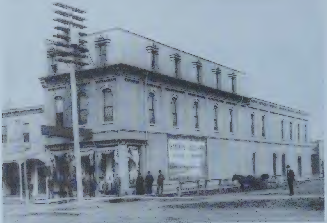
L'édifice Gariépy et Lessard, en 1903 : situé au coin nord-ouest de la 100 e rue et de l'Avenue Jasper. APA B4150
