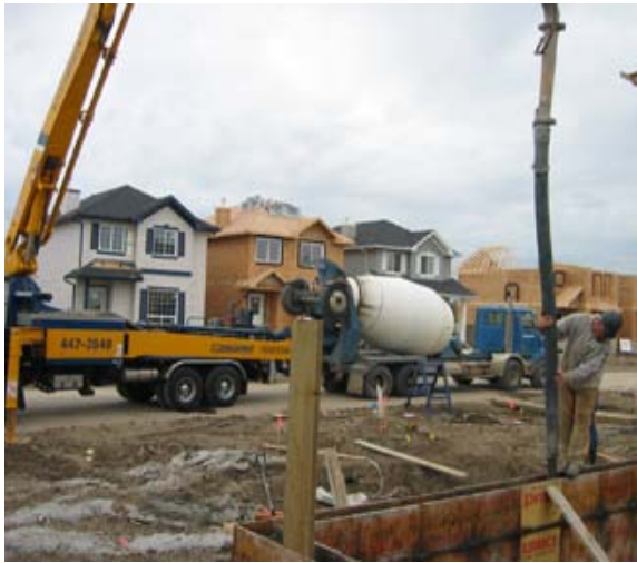
Pouring concrete walls
