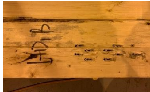
(d) Wood crushing.
