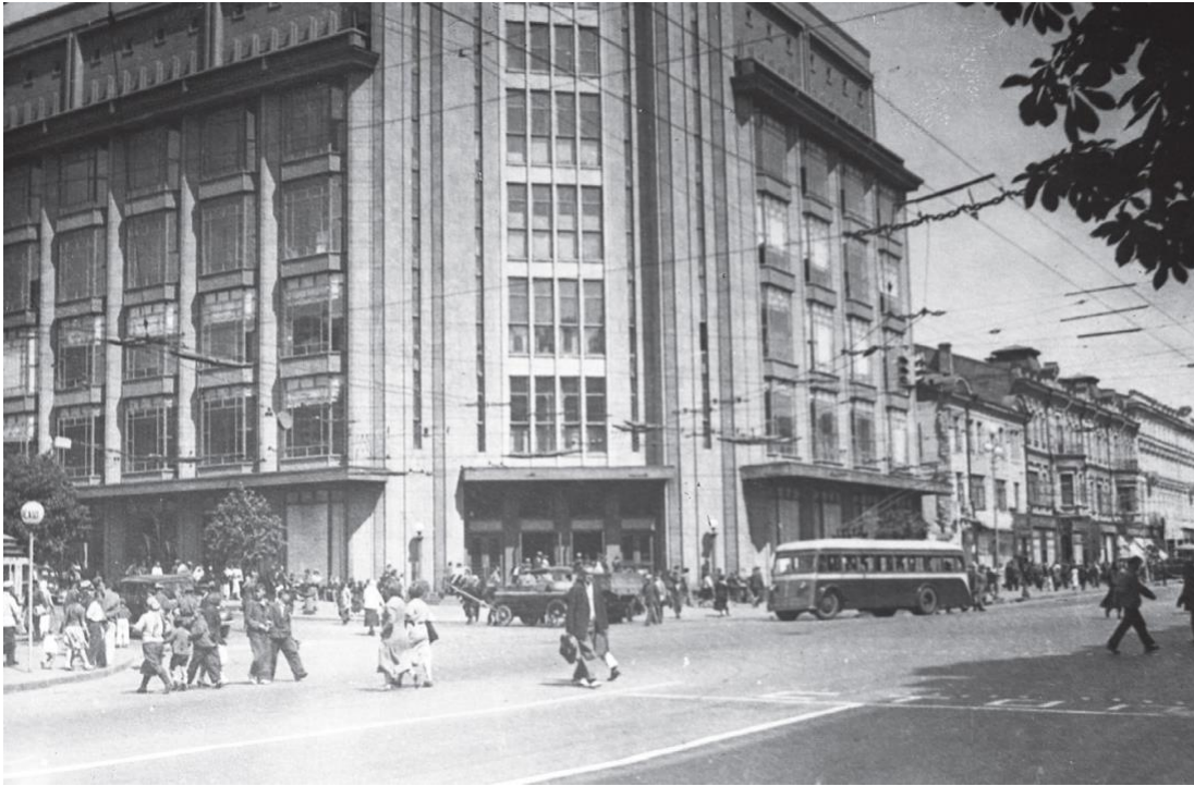
Іл. 3. Загальний вигляд будівлі ЦУМу в Києві, 1930-ті роки. 2-40412. Центральний державний кінофотофоноархів України ім. Г. С. Пшеничного, Київ, Україна.
