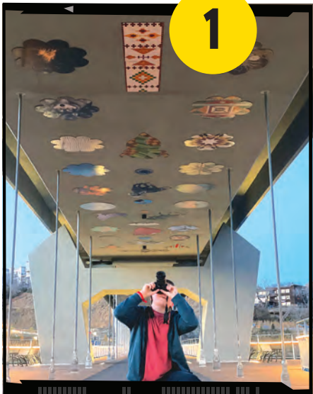
↑ Le pont Tawatinâ est un nouveau pont utilisé par les gens comme réseau de transport actif (vélo, à pied) et possède des œuvres autochtones partout sur le dessous de sa toiture. Crédit : Nico Lapointe
