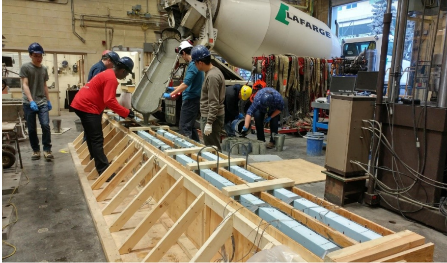
Figure A.6 Concrete pour
