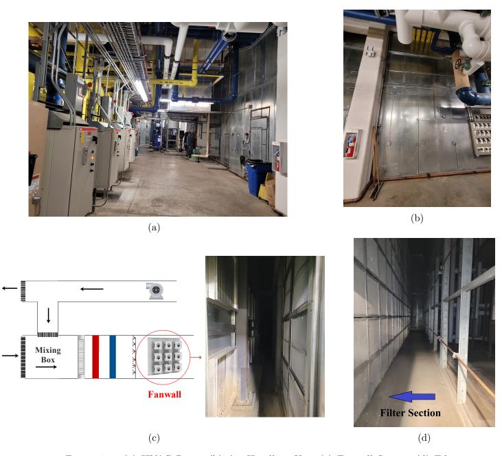
Figure 2.3: (a) HVAC Room (b) Air Handling Unit (c) Fanwall System (d) Filter Section
